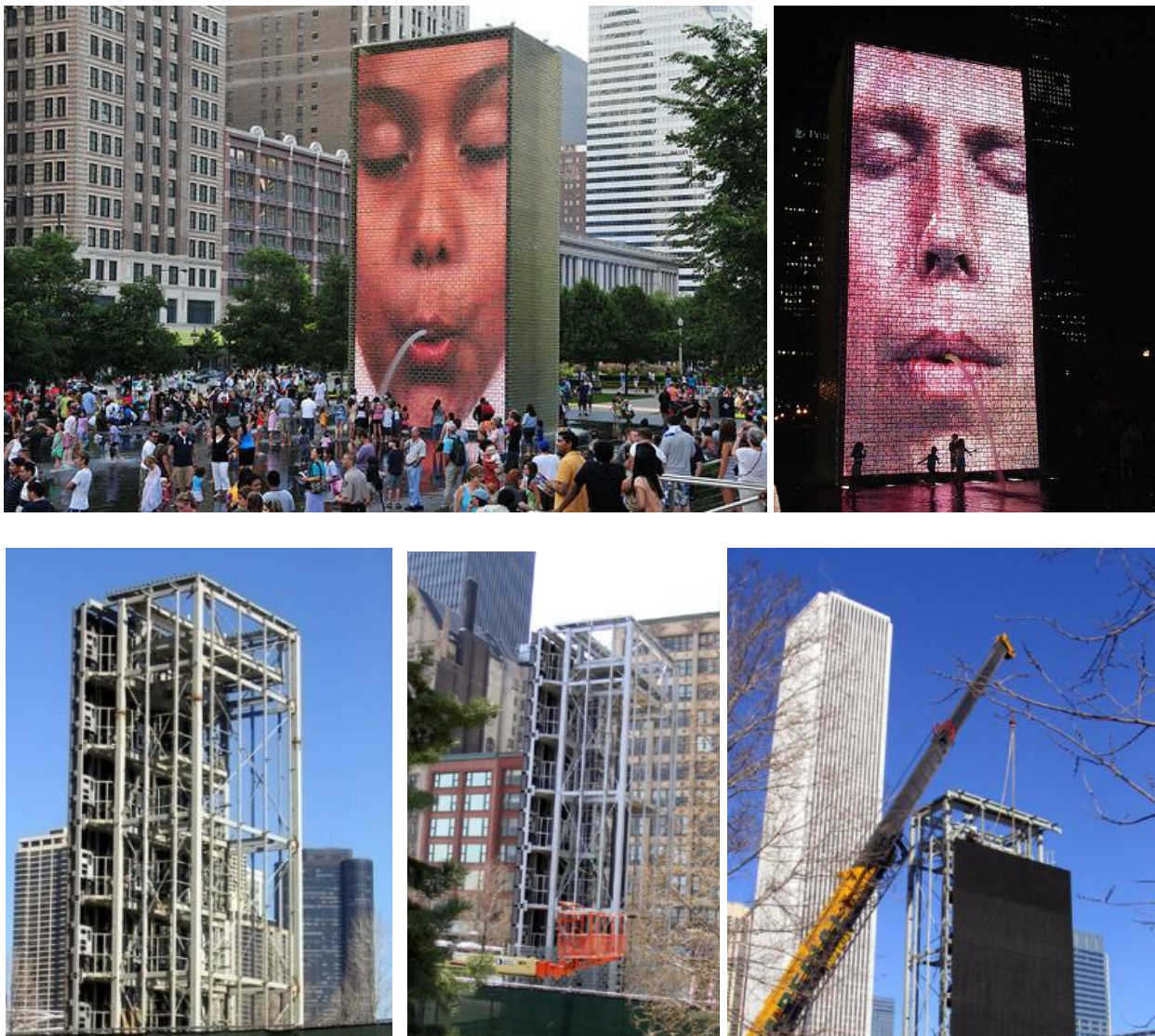
مراحل اجرای آب نمای دیجیتالی کرون- شیکاگو
